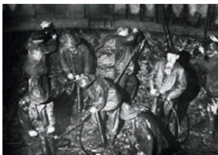
Die Schachthauer bei der Arbeit
