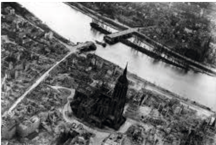
Zerstörte Oderbrücken in Frankfurt
