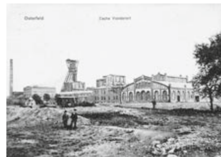
Die Zeche Vondern 1903 Der Schacht „Vondern 2“ ist noch im Bau.
