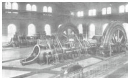
Zwei „doppeltwirkende Viertakt-Koksofengasmotoren mit 94 Uml./Min.“ treiben zwei 1 MW-Drehstromgeneratoren an, welche die elektrische Energie in das Ringnetz der GHH einspeisen.
