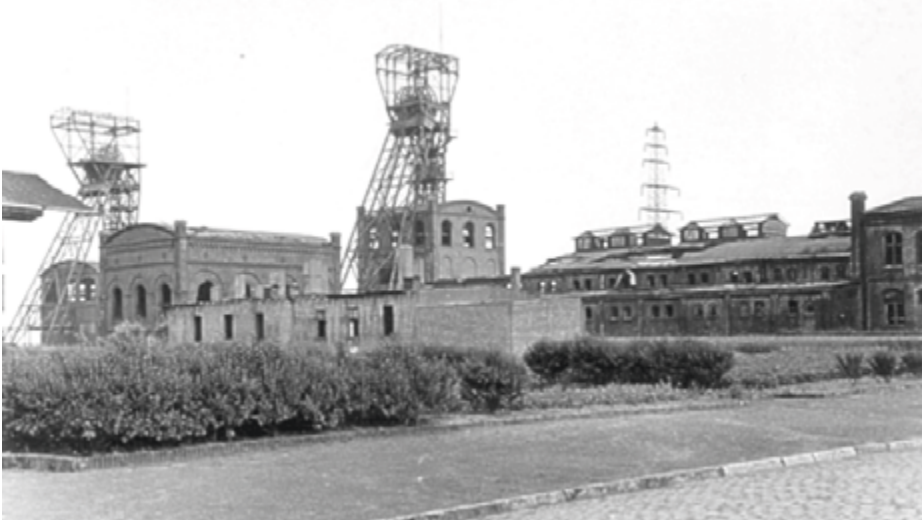
Obgleich nur noch der Grubenlüfter und eine elektrische Fördermaschine am Schacht 2 in Betrieb sind, bleiben viele Gebäude bis in die 1950er Jahre erhalten.
