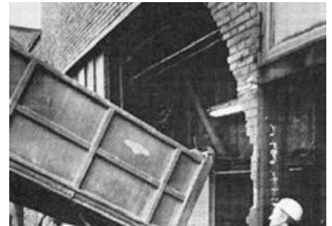
Die Schächte werden mit Waschbergen und Kies verfüllt
