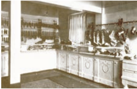
Das Ladenlokal der Metzgerei an der Essener Straße
