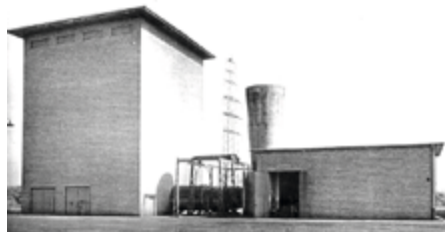
1956 wird am Schacht „Vondern 1“ ein neuer Grubenlüfter installiert. Eine luftdichte Schachthalle nimmt die Stelle des Schachtgerüsts ein.
