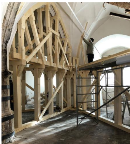
Abb. 3. Sondershausen, Notabstützung der Sternengewölbe im Schloss (Foto: Stiftung Thüringer Schlösser und Gärten, M. Mucha).
